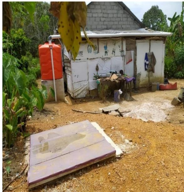
**Gambar 9. Penutup Sumur Resapan**
