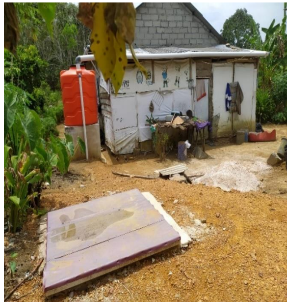
Gambar 9. Penutup Sumur Resapan
