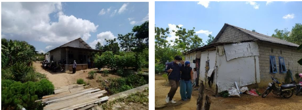
Gambar 2. Survey Lapangan dan Pengukuran Untuk Pembuatan Penampung Air Hujan (PAH) di Desa Jada Bahrin
