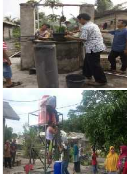
Gambar 3.3 Pembuatan Alat Penyaringan dan Konstruksi Pengolahan Air Sumur
