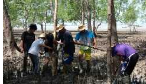
Gambar 3. Pemancangan tiang pancang secara manual sebagai pondasi untuk pembangunan jembatan di sekitar Hutan Mangrove
