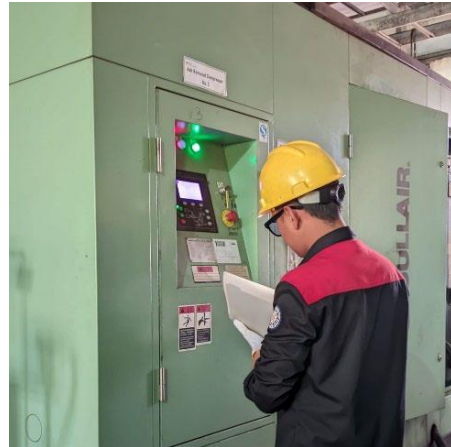
Gambar 5. Pengambilan data tekanan dan temperatur keluar kompresor
