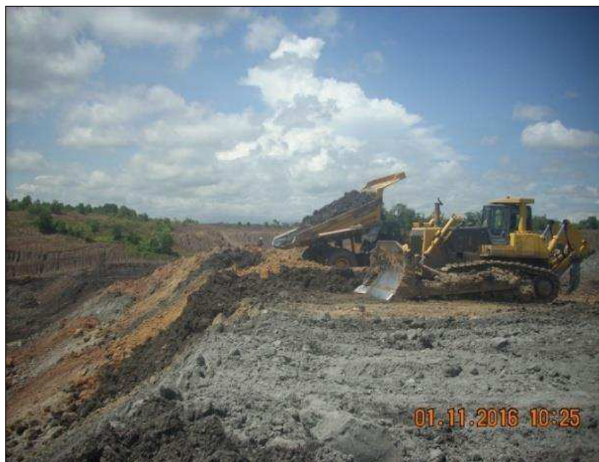
Gambar 4. Penimbunan tanah di DisposalArea Pit 3 Timur Banko Barat
