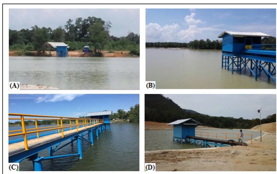
Gambar 2. Foto: (A) Sumber air baku Kolong Merawang, (B) Sumber air baku Kolong PLN Merawang, (C) Sumber air baku Kolong Tirta Pinang, dan (D) Sumber air baku Kolong Argo Tirto
