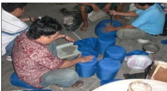
Gambar 2. Pembuatan geotube
