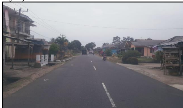
Gambar 4. Kondisi Ruas Jalan Pangkalpinang-Koba
