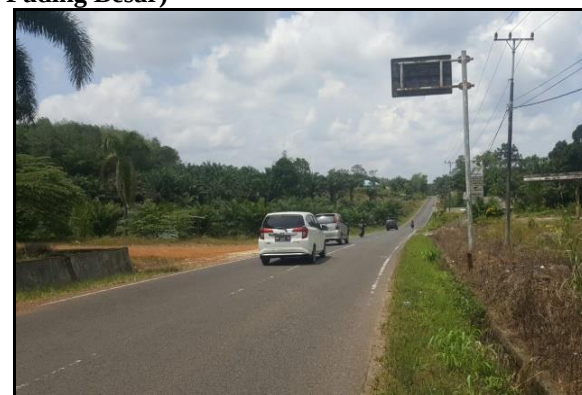
Gambar 3. Kondisi Ruas Jalan Pangkalpinang-Muntok
