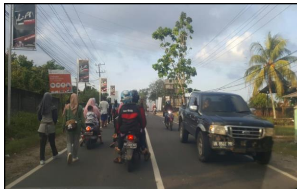
Gambar 2. Kondisi Ruas Jalan Pangkalpinang-Sungailiat
