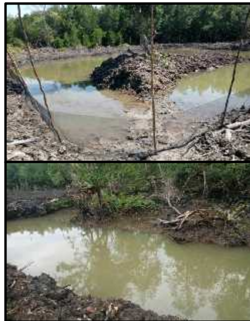
Gambar 3. Kondisi tambak setelah perbaikan
