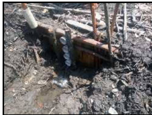
Gambar 4. Pintu Air Tambak
