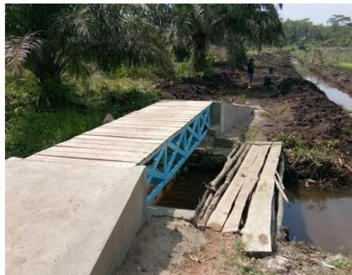
Gambar 9. Pembuatan Oprit Jembatan
