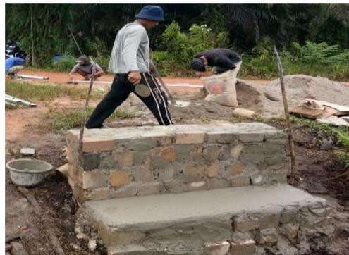
Gambar 6. Pembuatan Pondasi dan Abutment Jembatan
