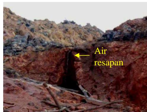
Gambar 3. Air resapan pada *Front 2*
