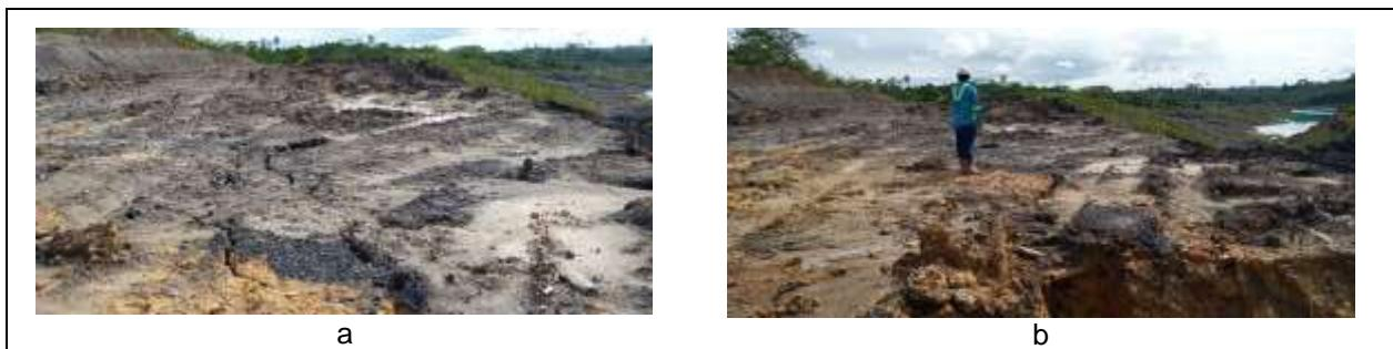
Gambar 4. Kondisi batuan : (a) lereng *sidewall* yang mengalami rekah tarik, dan (b) *slope cut* di *sidewall*
