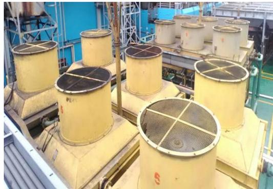
**Gambar 7.** Posisi Fan Radiator JW dan ICW
